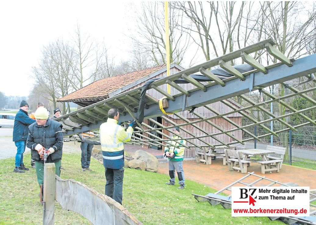
Weil die Welle ausgetauscht wird, musste die Mühle in ihre Einzelteile zerlegt werden.
